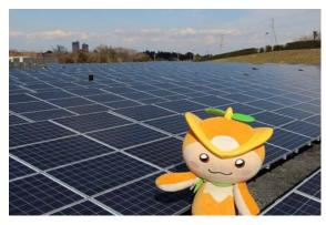
埋立が終了した北野一般廃棄物最終処分場を利用して太陽光発電施設「メガソーラー所沢(愛称: とことこソーラー北野)」の運営を 26 年 3 月より開始しています。発電能力は一般家庭約 260世帯で使用する電気量に相当し、1 年間で35,700本の杉の木が吸収する CO2量の温暖化防止効果があります。(所在地:北野南3丁目16番地の24、パネル枚数:4,298枚)
