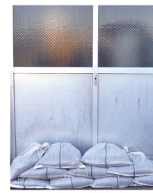
③扉や玄関の前など、浸水が想定されるところに隙間なく重ねておきます。
