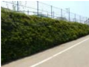
図 1-2-19 緑化擁壁の例
