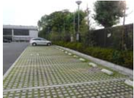
図 1-2-27 駐車区画の芝生による緑化の例 (新所沢まちづくりセンター)
