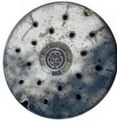
昭和34年度から設置が開始された鉄筋コンクリートの蓋。
