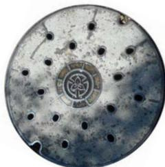
昭和34年度より設置が開始された鉄筋コンクリートの蓋。
