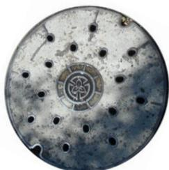
昭和34年度から設置が開始された鉄筋コンクリートの蓋。
