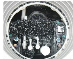
○送風機（ブロー）の電源は絶対に切らないでください。浄化槽内の微生物が死滅してしまいます。
